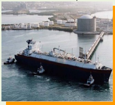
Planta Eco Eléctrica, Peñuelas
